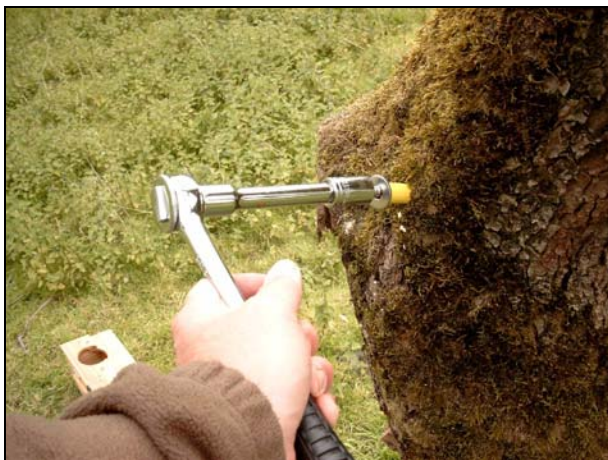
5 Bout aanbrengen (evt. voorboren)
